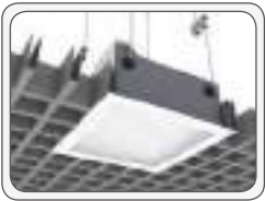
Монтаж в потолки Грильято
